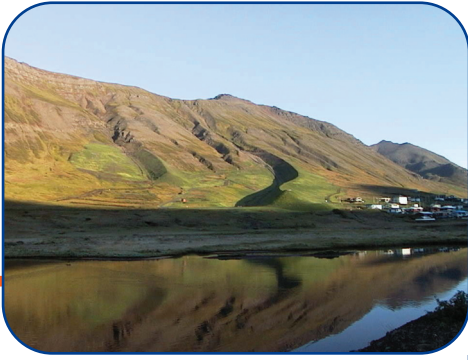
Siglufjörður. Varnargarðarnir beina snjóflóðum úr Strengsgiljum og Jörundarskál fram hjá suðurhluta byggðarinnar.
